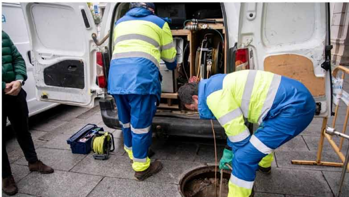
TRABAJADORES AYUNTAMIENTO SANEAMIENTO
