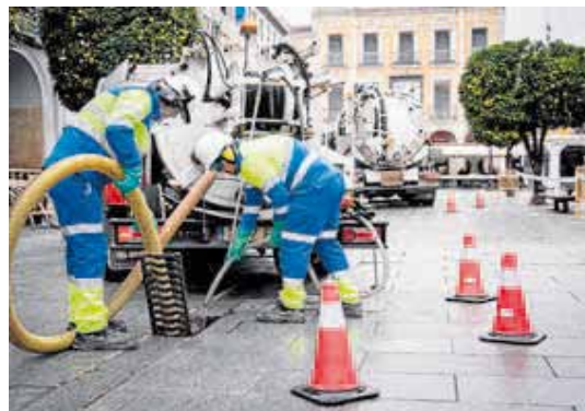
Operarios de Aqualia limpiando las alcantarillas. hoy
