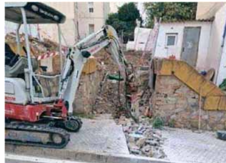
Trabajos municipales en la calle Espíritu Santo, en La Piñera. VIVA CC
